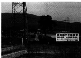
写真3 4月18日重機掘削
