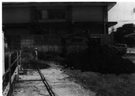
重機作業風景
