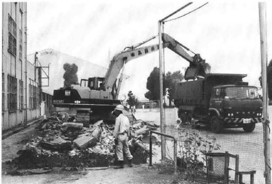
重機による部室取り壊しスナップ
