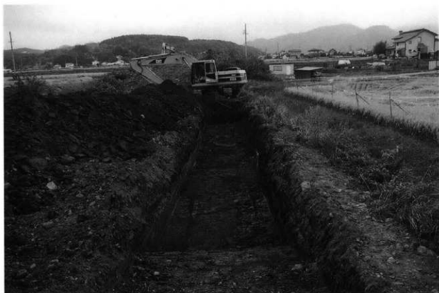
遺構確認作業（手前）及びび壊土除去作業（奥） 南から
