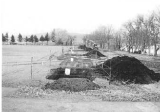
2.柳原道跡 重機による埋め土の除去
