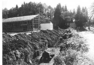
8.上ノ原遺跡 下水道管敷設工事に伴う調査の様子
