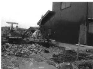
御料遺跡 (No11) 工事立会
