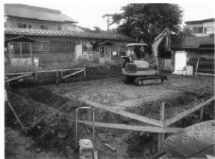
小丸山公園遺跡 (No.5) 工事立会
