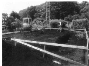
小丸山公園遺跡 (No.6) 工事立会
