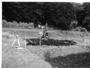
川久保遺跡 工事立会
