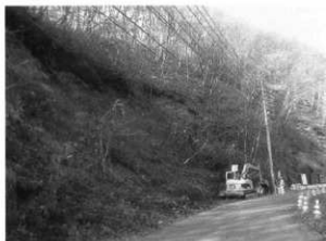
家老路城跡 工事立会
