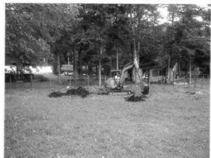
海端遺跡 工事立会
