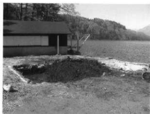
桐久保遺跡 工事立会
