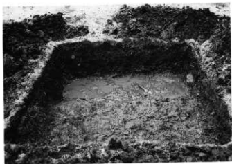
No. 1 グリッド完掘状況
