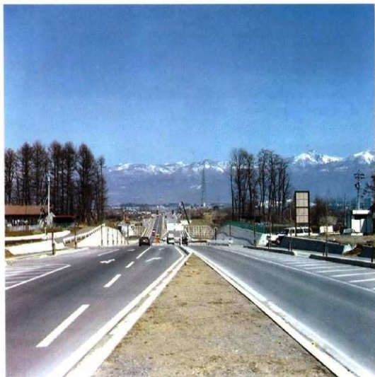
写12 中西ノ久保遺跡Ⅱ・仲田遺跡・寺畑遺跡Ⅱ工事終了状況（南から）
