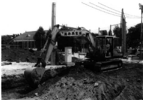
重機作業風景
