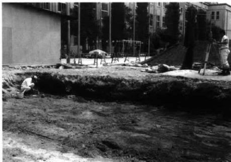
基準点設置作業
