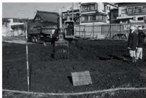
Ⅱ区表土剥ぎ作業風景
