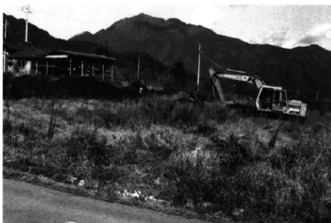
北方大原遺跡重機作業風景
