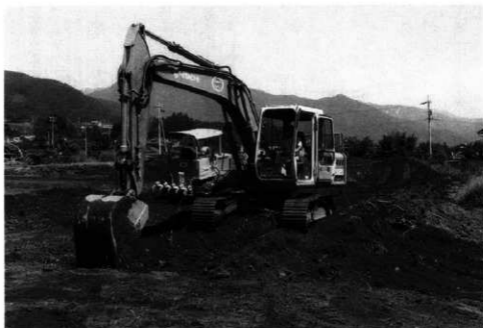
富士塚遺跡重機作業風景
