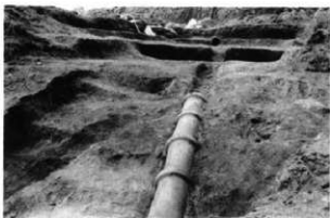
窠址の中央に埋められた排水口管
