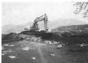
バックホーによる表土剥ぎ作業
