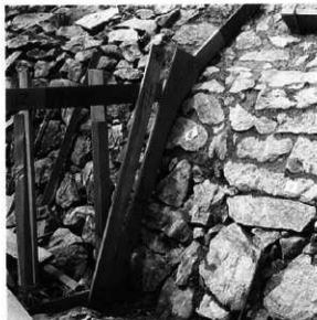
図14 積石垣交換部の施工
