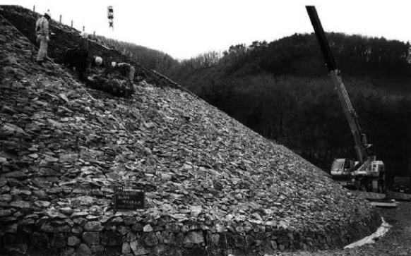
写真6 補修工事状況(1)
