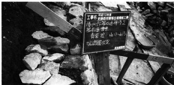
図10 裾石垣修復工
