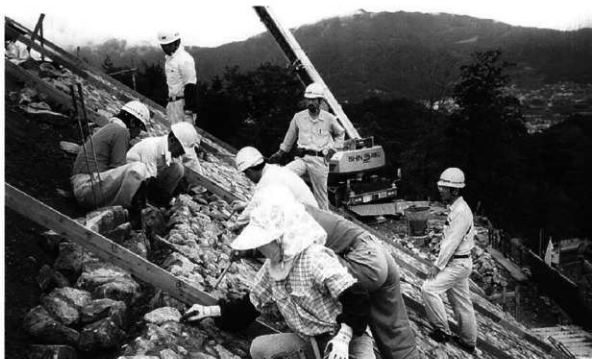
後円部北側 丁張りNo17~18の間 砕石設置、目地詰め工
