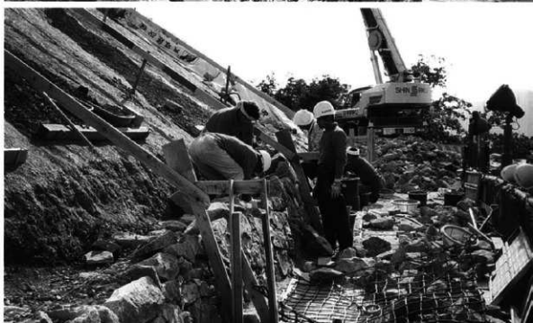
後円部北側 丁張りNo18付近 柵石垣積み工 変換部に控え力石を設置
