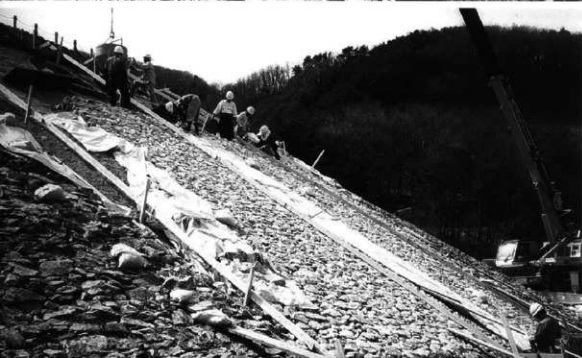
後円部西側 丁張りNo20～23の間 礫石設置工 5工区に分け順次施工
