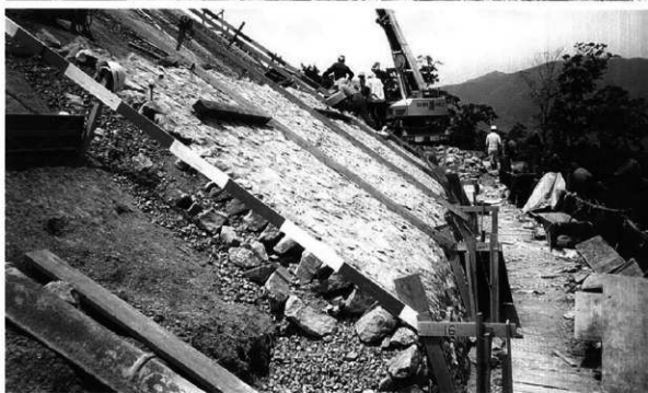
後円部北側 丁張りNo16付近 砕石下地を砕石に変更
