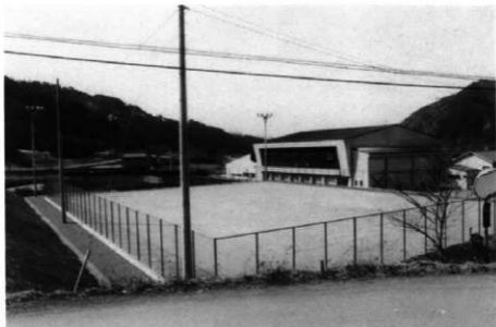
発掘調査後完成した村営庭球場
