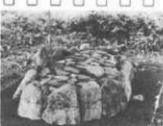
④インサルパックの発泡が硬化したら型枠をはずし、周囲の土砂を取りのぞいていく。
