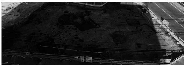
1-17 F区全景 (南面より)
