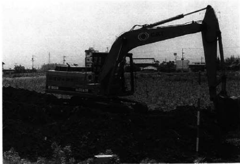
重機作業風景
