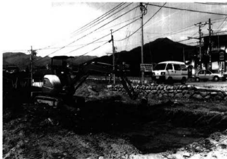
重機作業風景
