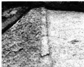
同上(粘土塊を除去した状態)
