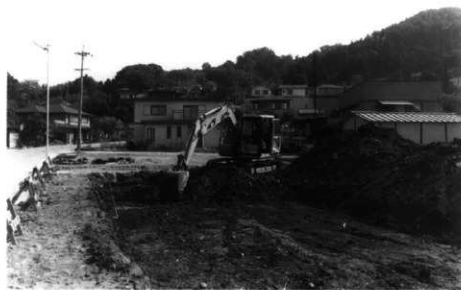
重機作業風景
