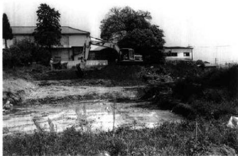
重機作業風景
