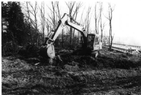
重機作業風景
