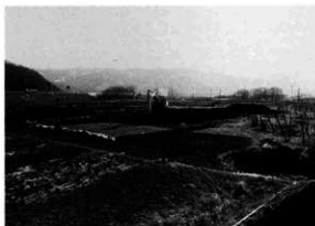
I-1 A区表土除去
