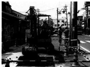
No①トレンチ (D4区)の重機掘削
