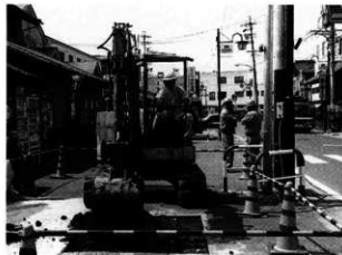
No①トレンチ (D4区)の重機掘削
