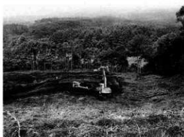
写真14 B区重機表土剥ぎ作業
