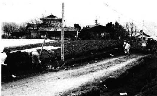
矢崎地籍重機による石垣除去作業
