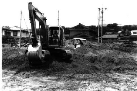
重機作業風景
