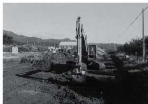
重機表土剥ぎ
