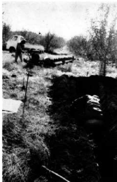
狭い溝の中の調査
