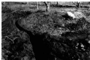
赤坂古墳の西側に配管溝が掘られる—右下に築道部とみる敷石が発見され、さらに溝は西に迂回する
