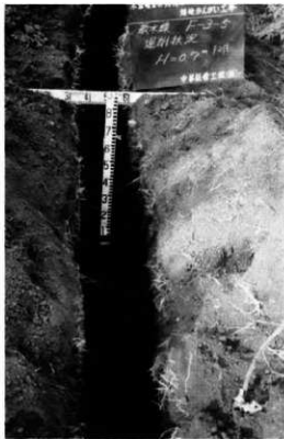
配管溝の幅と深さ
