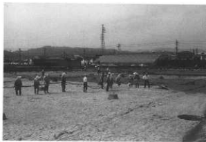
歴代遺跡群②区 広大な桑里水田面での散水作業
