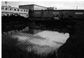
I-1 湧水による冠水
