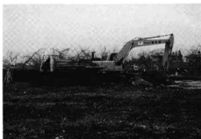
I-1 表土除去
