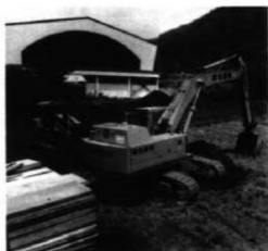
ブルドーザとユンボによる表土取り
