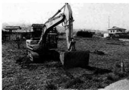
写真12 重機による表土剥ぎ
