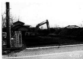
写真1 A区重機表土剥ぎ作業
