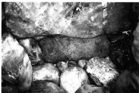
玄室 天井石（最奥部は後補とされる）
