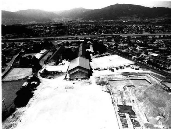
調査地近景 (東側より)
