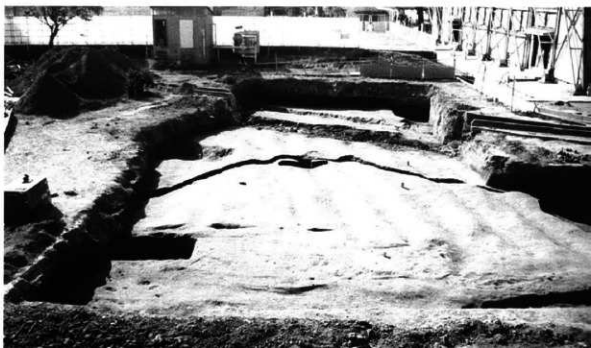
竈状遺構 (東側より)
