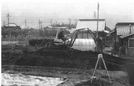
YKS 3450-1 重機作業風景
