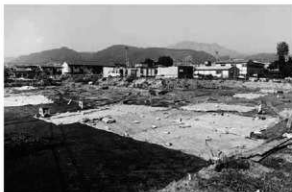
A区表土除去後（南東から）
