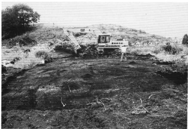
▲ 重機による表土除去作業
