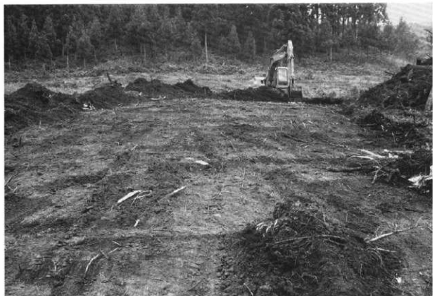
▼ 重機による表土除去作業
