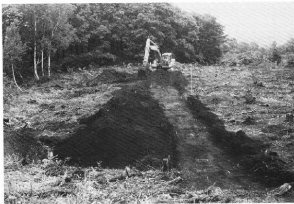
▲ 重機による表土除去作業
