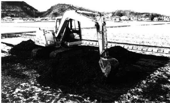
バックホーによる表土掘削
