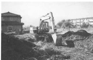
3号トレンチ掘削状況(東より)
