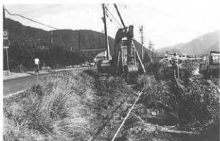
トレンチ掘削状況（北より）
