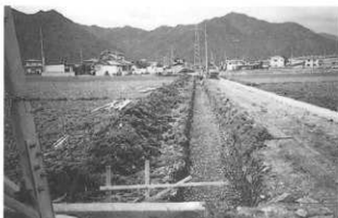
遺跡近景（南より）
