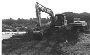
重機による表土剥ぎ
