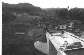
現場事務所の設置
