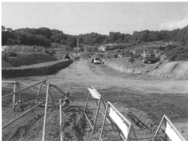
道路工事中の唐松B遺跡
