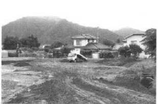
埋め戻し状況（北東より）
