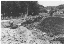
遺構検出作業 (みどり湖入口)
