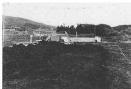
重機による表土除去 (平成4年度)
