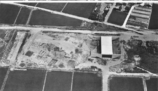
遠景 (西上空から)
