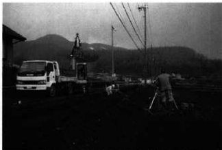
測量作業風景(道路工事がせまる)
