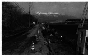
1c区表土削ぎと検出作業
