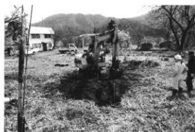
2. 表土除去(北西から)
