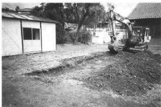
バックホーで表面の土を取り除いているところ
